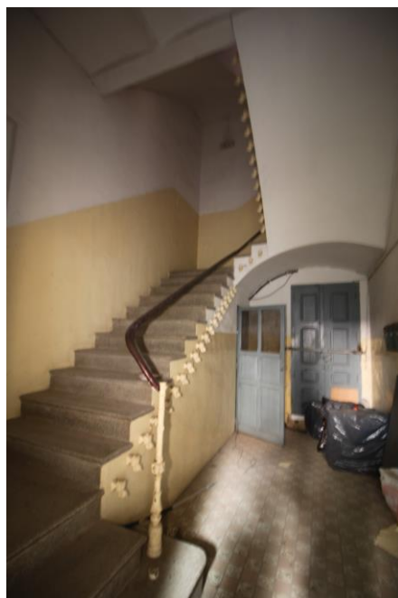
Escalera de 4 tramos vista desde la planta baja
